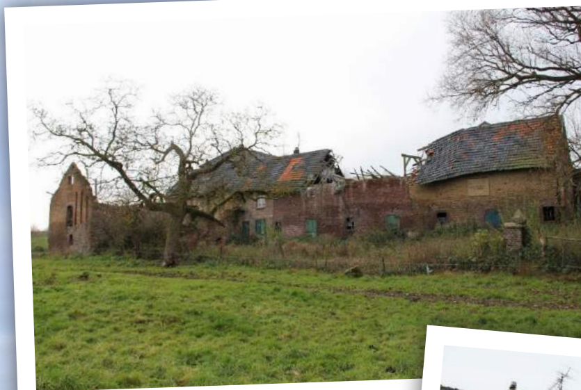
Zo zag de zijkant er uit bij de start van de restauratie. Nu is het een fijn terras.
