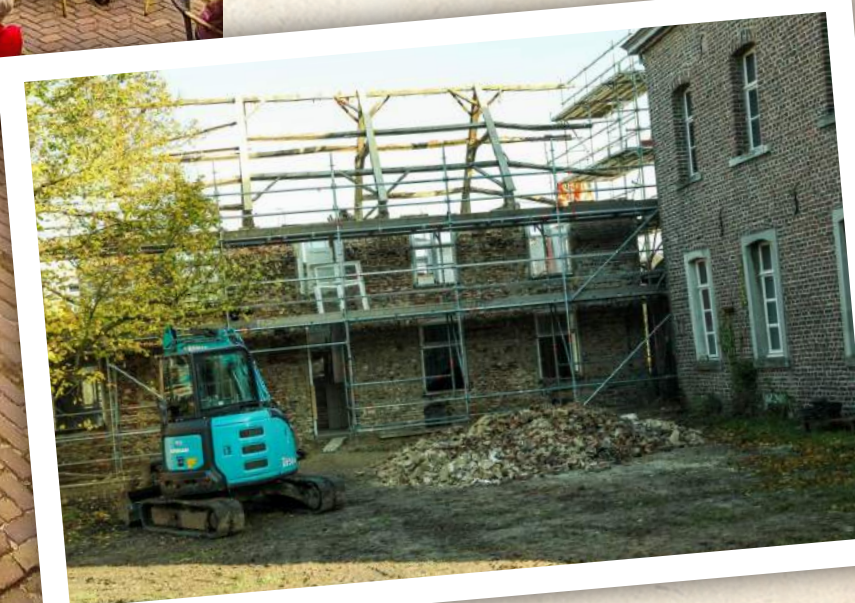
Het dak en de gevel aan de binnenplaats moesten volledig worden vervangen.
