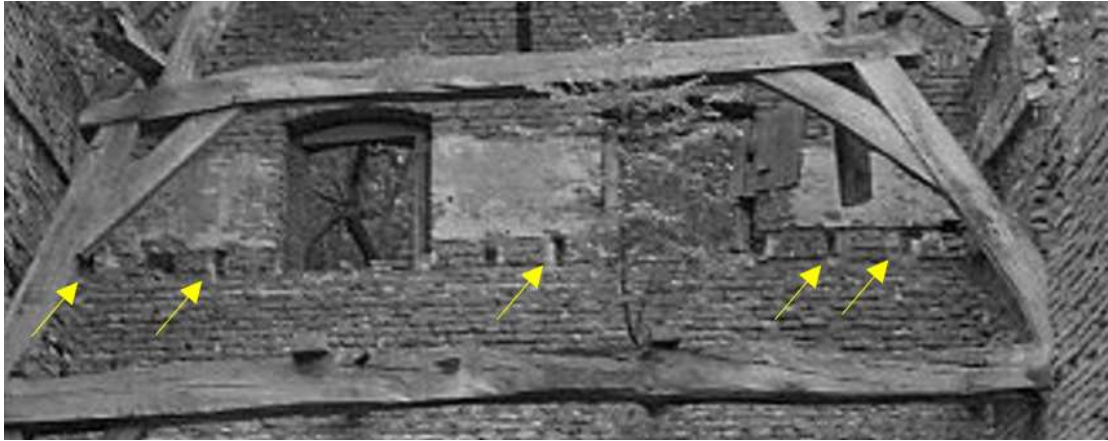
Detail van een foto uit 1980. Hierop zien we het oorspronkelijke gestapelde spant. De gele pijlen geven enkele van de lege gaten van een kinderbalklaag aan. Deze kinderbalklaag zit ter hoogte van de aanzet van het metselwerk uit 1867. De nieuwe vloerhoogte houdt geen enkel verband tot de bestaande structuur van de gestapelde spanten.
