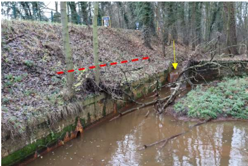
De Molenbeek, gezien vanaf het terras van de Wijmarsche watermolen. Op de achtergrond de keermuur met sluis (gele pijl). Ruwweg ter hoogte van deze keermuur moet ergens de 1,7 meter dikke muur in het talud zitten (rode stippellijn).
