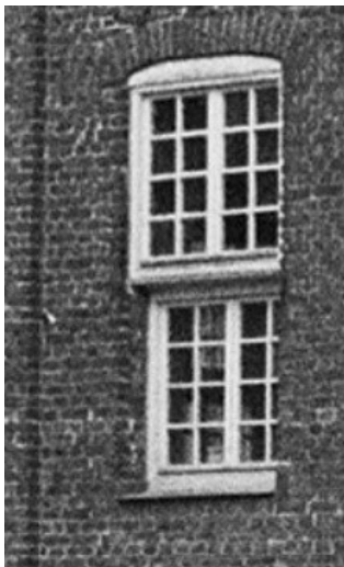
Detail van de twee types toegepaste kruiskoziijnen (voorzien van twee boven elkaar geplaatste stolpramen), aangebracht door Deusser. Dit type venster verwijst in hoofdopzet naar de oorspronkelijke zeventiende-eeuwse situatie.
