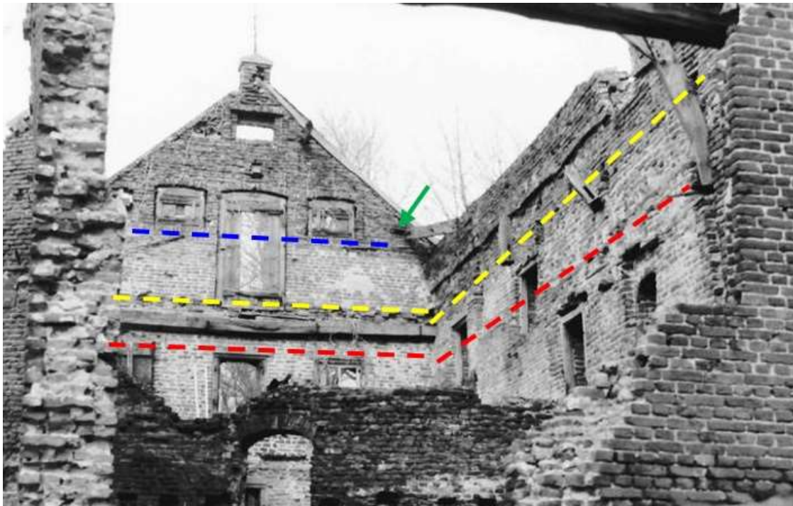
Foto uit circa 1985. In rood de hoogte van de oorspronkelijke moerbalklaag. In blauw de hoogte van de oorspronkelijke dekbalk van het zoldergebint (gebaseerd op de hoogte van de oorspronkelijke gordingen: groene pijl). In geel de hoogte van de secundaire zoldervloerconstructie, aangebracht in 1867.
