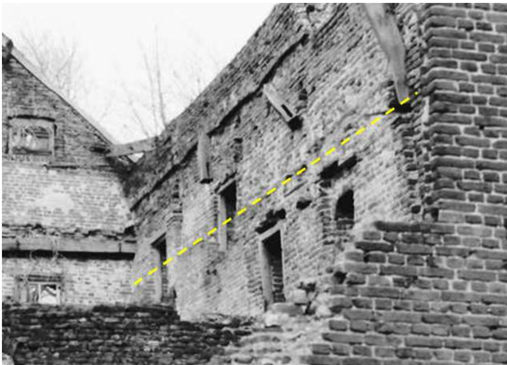
Foto uit circa 1985. De gele stippellijn geeft de hoogte van de moerbalklaag weer. Deze zaten over de gehele lengte van de molen op hetzelfde niveau.
