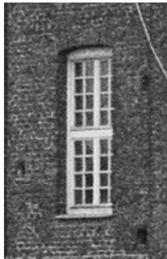
Detail van de twee types toegepaste kruiskoziijnen (voorzien van twee boven elkaar geplaatste stolpramen), aangebracht door Deusser. Dit type venster verwijst in hoofdopzet naar de oorspronkelijke zeventiende-eeuwse situatie.
