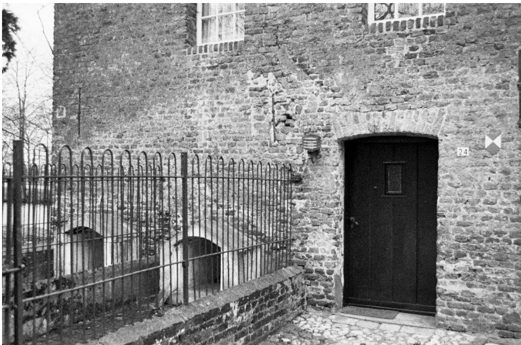
De negentiende-eeuwse hondenhokken op een foto uit 1986. Op deze foto is duidelijk zichtbaar hoe de hokken tot diep in het volume doorlopen.
