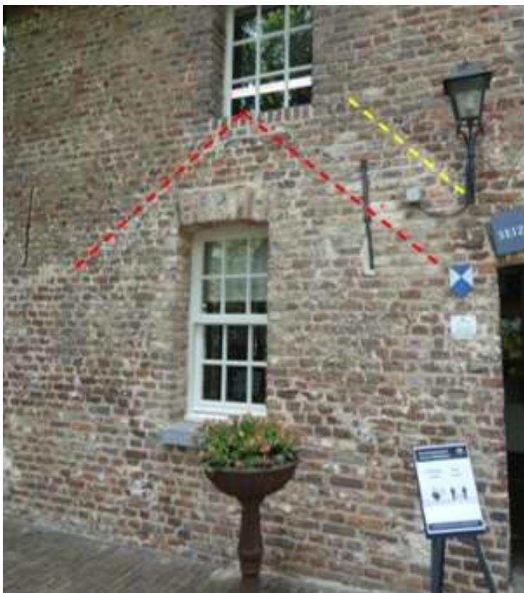
Het zuidelijke deel van de oostgevel van de zuidwest vleugel. Hierop zijn twee aparte sporen van dakaanhechtingen zichtbaar (rode en gele stippellijn). In hoeverre deze sporen een verband houden tot de verdwenen dwarsvleugel, is onduidelijk. Met name de gele lijn lijkt een relatie te hebben met de oorspronkelijke opzet.
