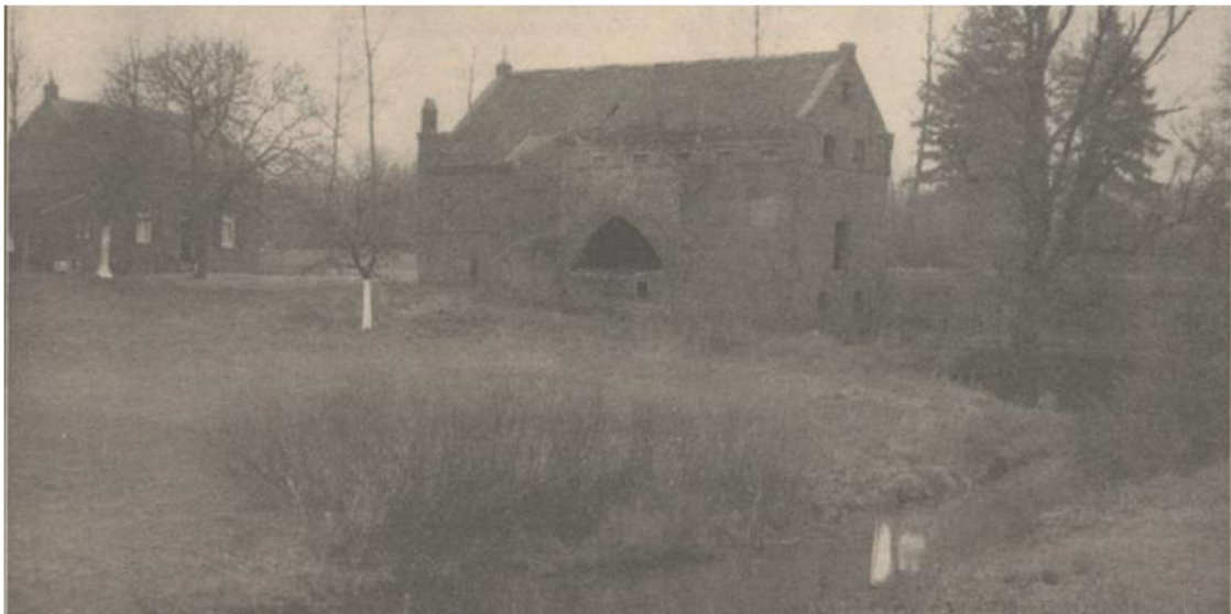
Foto uit 1934. Hierop is het verloop van de voormalige helling goed zichtbaar. We zien hier ook dat het dak al in een slechte staat verkeert en dat de spitsboog tot halverwege is dichtgezet. In het bijschrift wordt gesproken over de vervallen molen: "waar eens het molenrad draaide, kolkt en bruist nu het water, dat steen na steen van deze ruïne loswerkt en meesleurt".
