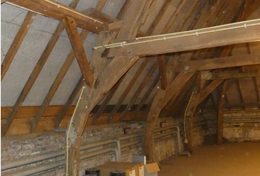
Spanten in de noordelijke zolderruimte van de zuidwestvleugel, waarbij het zoldergebint is opgezet met een tussenbalk.
